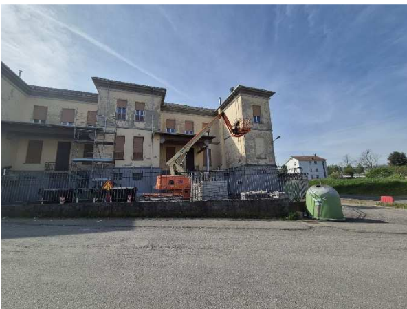
Manutenzione straordinaria facciate ed efficientamento energetico Scuola Elementare A. Ferrari
