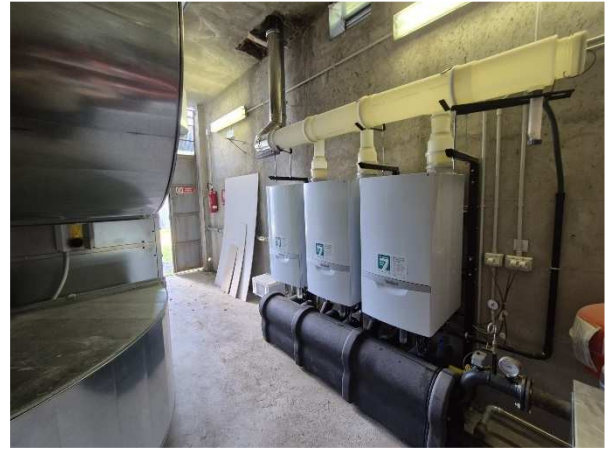
Efficientamento energetico Palazzetto dello Sport: nuova caldaia
