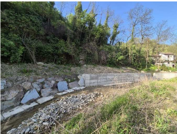
Ripristino della viabilità S.C. Rovinale con sistemazione idrogeologica del Rio Sereigo e dei soprastanti versanti in dissesto
