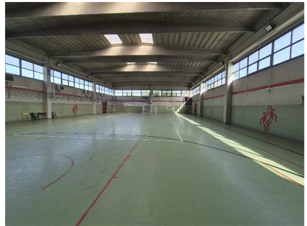
Efficientamento energetico Palazzetto dello Sport: nuovi infissi
