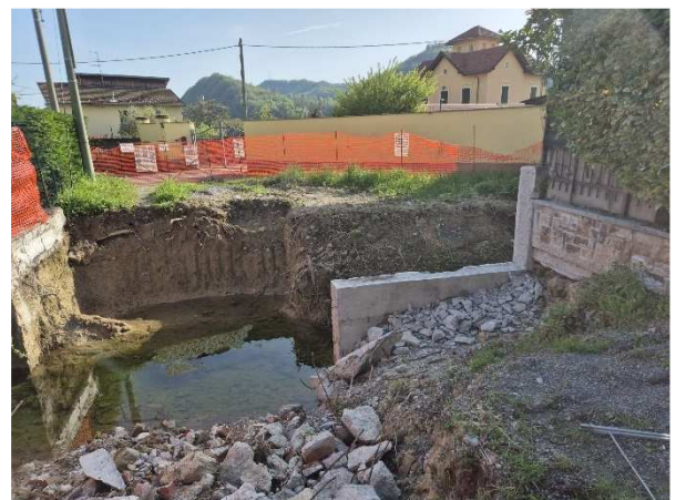
Lavori di sistemazione alveo e regimazione acque Rio Riarello
