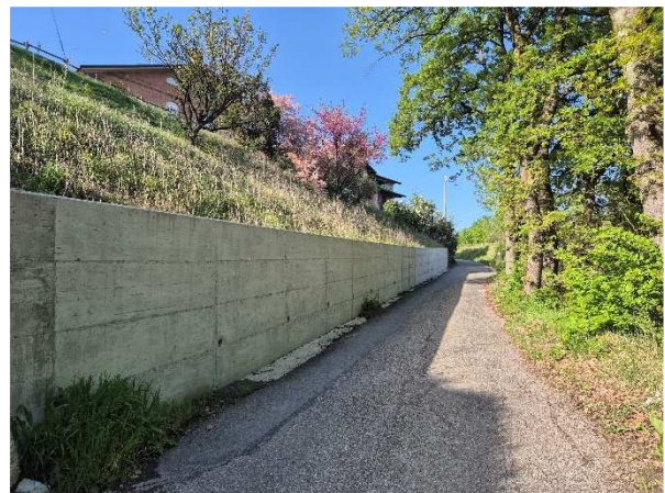
Ricostruzione tratto muro di sostegno strada Comunale della Capanna
